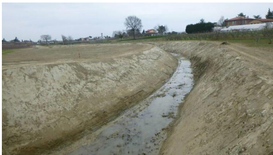
Figura 8 I lavori sull'argine del torrente Pisciatello a Calisese di Cesena
